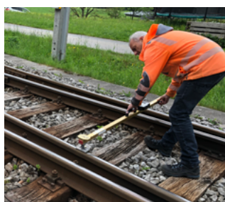
Mesure d'une inspection d'aiguillage
