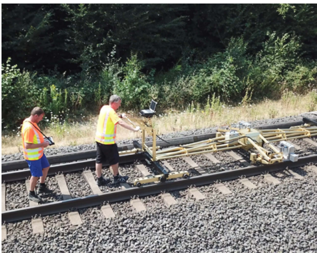
Mesure de la géométrie de la voie avec EMA uni
