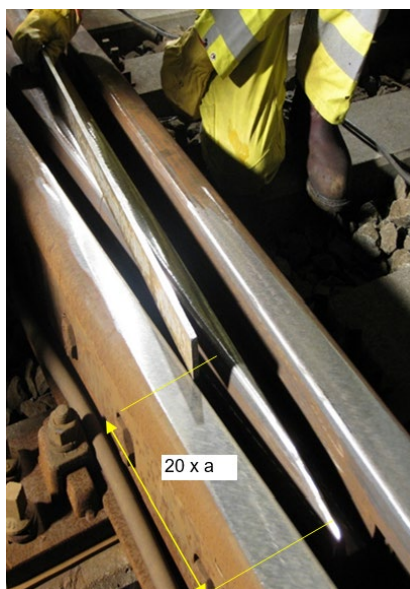
Afbeelding 14; Vleugelhoogte bepalen
