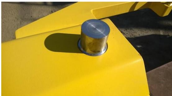
Steckbolzen in Drehschwelle
