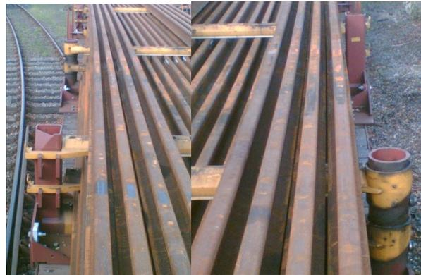
ohne Steckbolzen: Schienen gleiten quer frei
