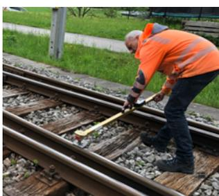
Vermessung einer Weichenprüfung
