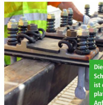
Die hochelastische Schienenbefestigung ist die ideale Rippenplattenlösung für die Anforderungen der Festen Fahrbahn.
