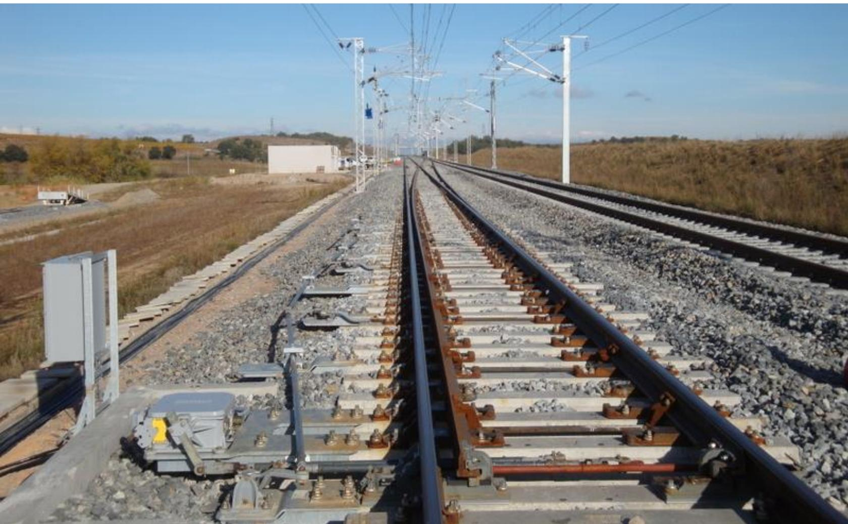
Cogilink Retrofit, système de manœuvre sans graissage
