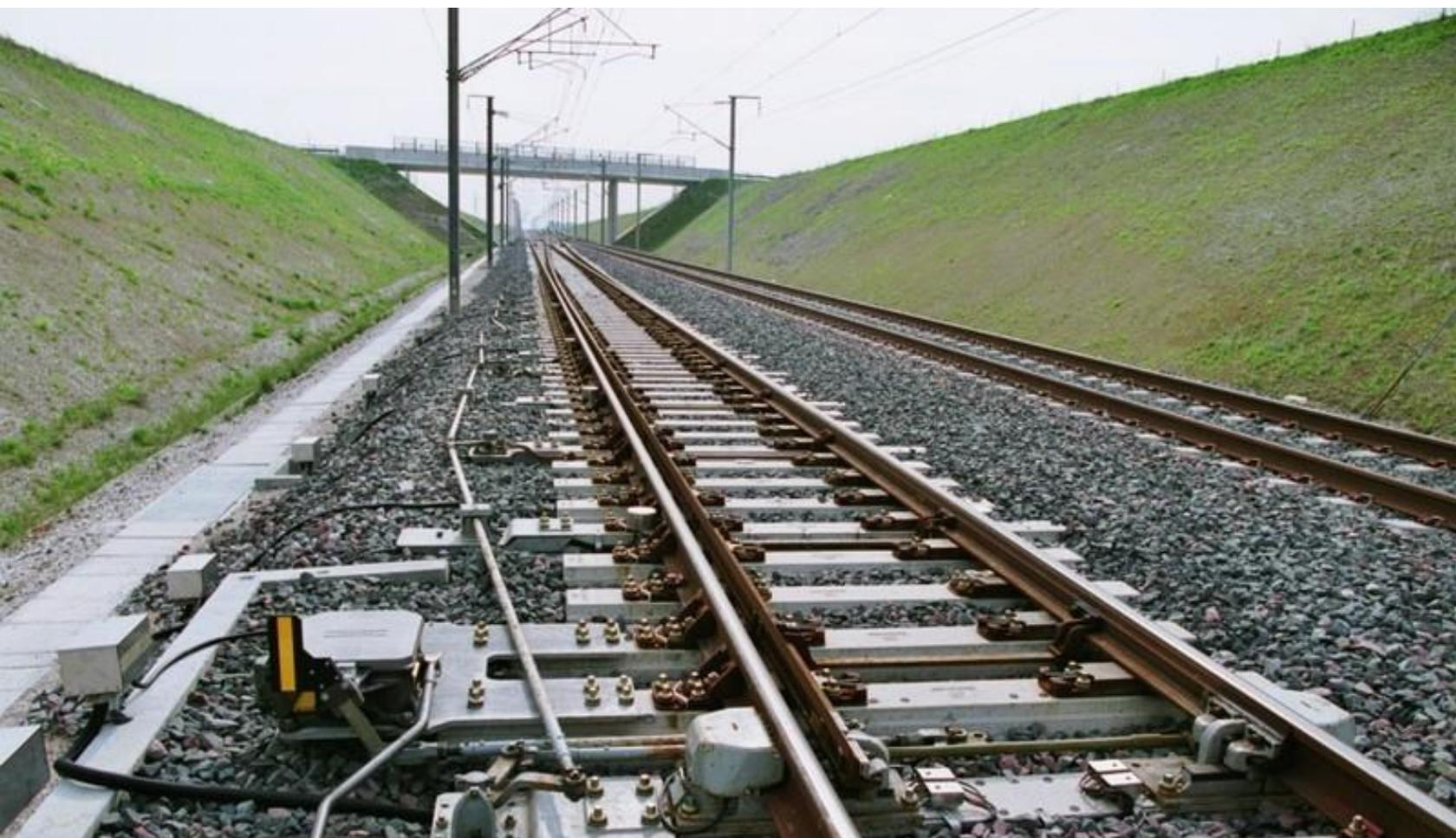
Cogilink : système de manœuvre sans graissage
